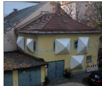
Bei den straßenseitigen Erdgeschossfenstern des Hauses **Liebigstraße 43** handelte es sich um einfache, schlecht gedämmte Metallfenster. Sie wurden gegen isolierverglaste Holzfenster ausgetauscht, die in Absprache mit dem Denkmalamt optisch allen anderen, noch originalen Holzkastenfenstern und der ornamentreichen „Art Deco“-Fassade angepasst sind (Bild unten).
