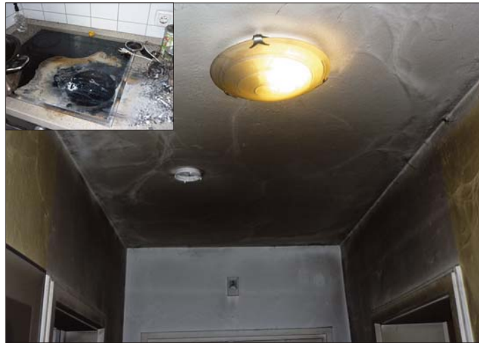
Der Schwelbrand am Herd hat die gesamte Wohnung verwüstet; im Bild die vom giftigen Rauch geschwärzte Decke des Flurs. Foto: bww
