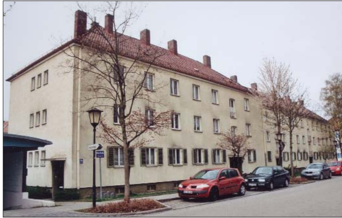
Eine Sanierung ist nur über hohe Mieten finanzierbar , daher wird der Haarer Wohnblock jetzt entmietet und abgerissen. Foto: cws
