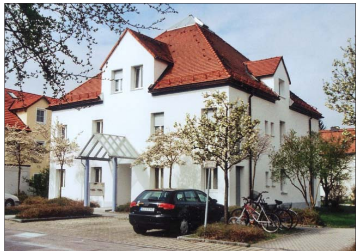
Schillerstraße 3 in Haar: Die Dämmwerte der 90er Jahre hielten den strengen Anforderungen der EnEV nicht mehr stand. Foto: cws
