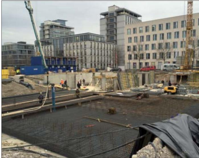
**Beton und Eisengitter** bilden das solide Fundament für das sechsstöckige Haus mit 46 Wohnungen
