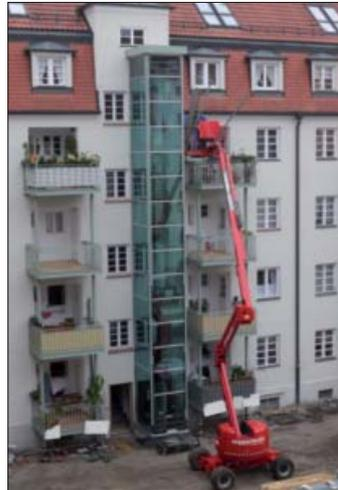
In der **Schwabinger Wohnanlage** ist die umfangreiche Maßnahme fast geschafft: Die fünf Aufzüge sind angebaut und die Loggien durch vorgebaute Balkone vergrößert (Bild rechts). Sechs der zehn Häuser haben bereits sanierte Fenster. Die hofseitige Fassade der betroffenen Häuser wurde neu gestrichen, außerdem die prächtig verzierte Fassade zur Clemensstraße nebst dem eifrigen Schreiberling über dem Hauseingang Nr. 50.
