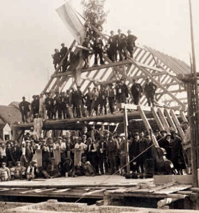
Richtfest in der Gudrun-/ Pötschnerstraße im Oktober 1924.
