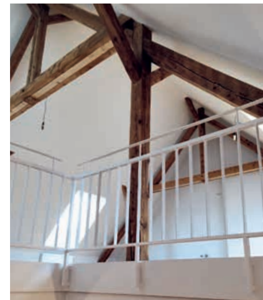
Dachgeschossausbau in Neuhausen.
