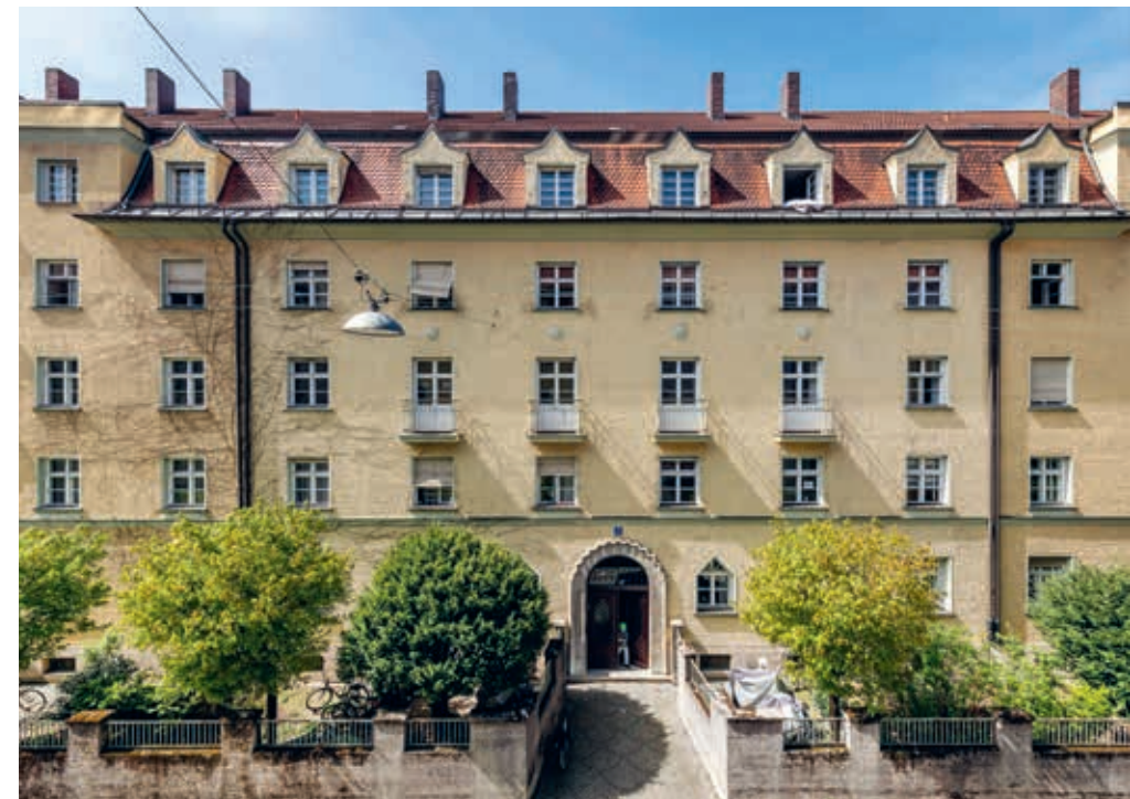
Die Fassade der Rossinistraße im Jahr 2020.
