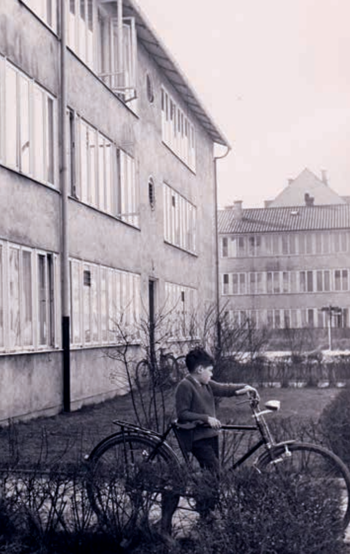
Die Messerschmitt-Häuser mussten in den 1980er-Jahren abgerissen werden.
